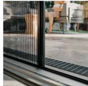
Barrierefreie, flache Führung unten* zum Aufkleben
